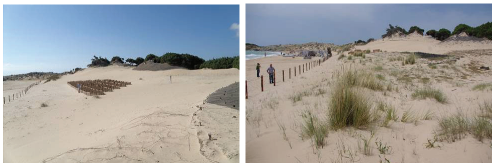
Figura 7 – Spiaggia di Porto Campana (Chia): schermi a scacchiera a ottobre 2009 (a sinistra) e a giugno 2014 (a destra).
