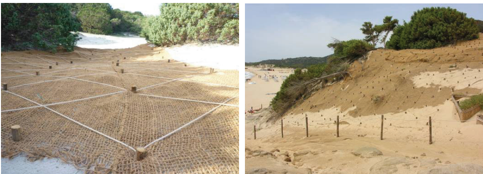
Figura 5 – Georeti in fibra di cocco (soprastanti) associate a stuoie in canne (sottostanti).
