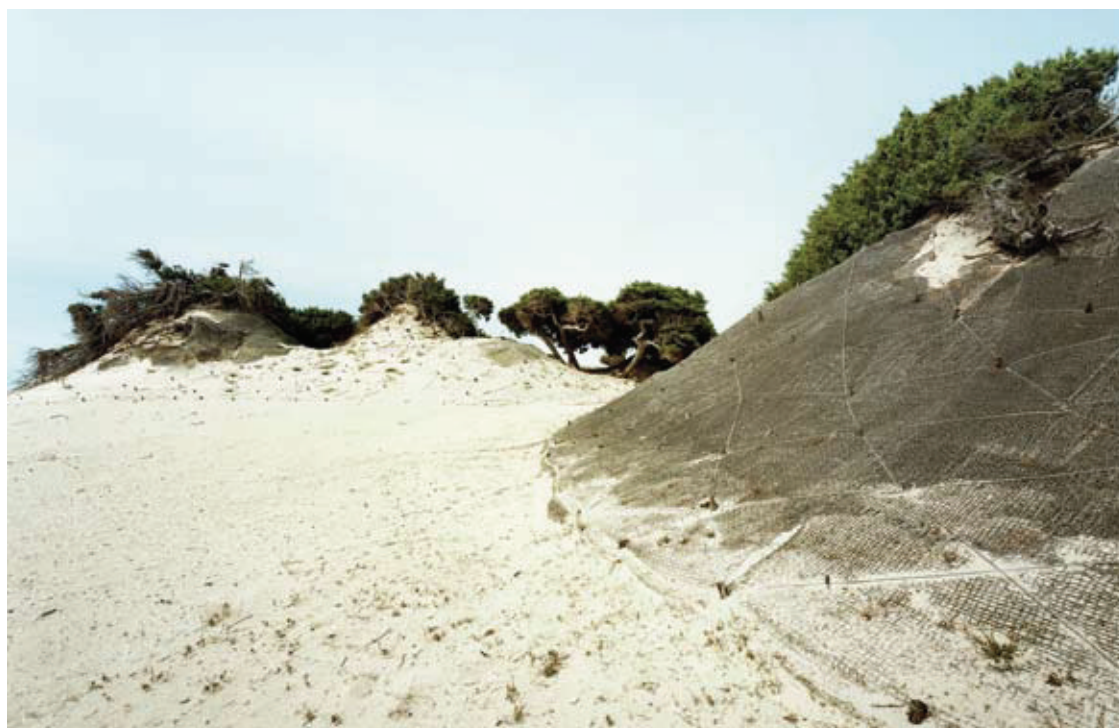
Interventi di risanamento delle dune a ginepro mediante biostuoie per la protezione delle superfici sabbiose e il rinnovamento della vegetazione erbacea ed arbustiva nel litorale di Chia, Domus de Maria (CA). (Foto di Davide Viridis).
