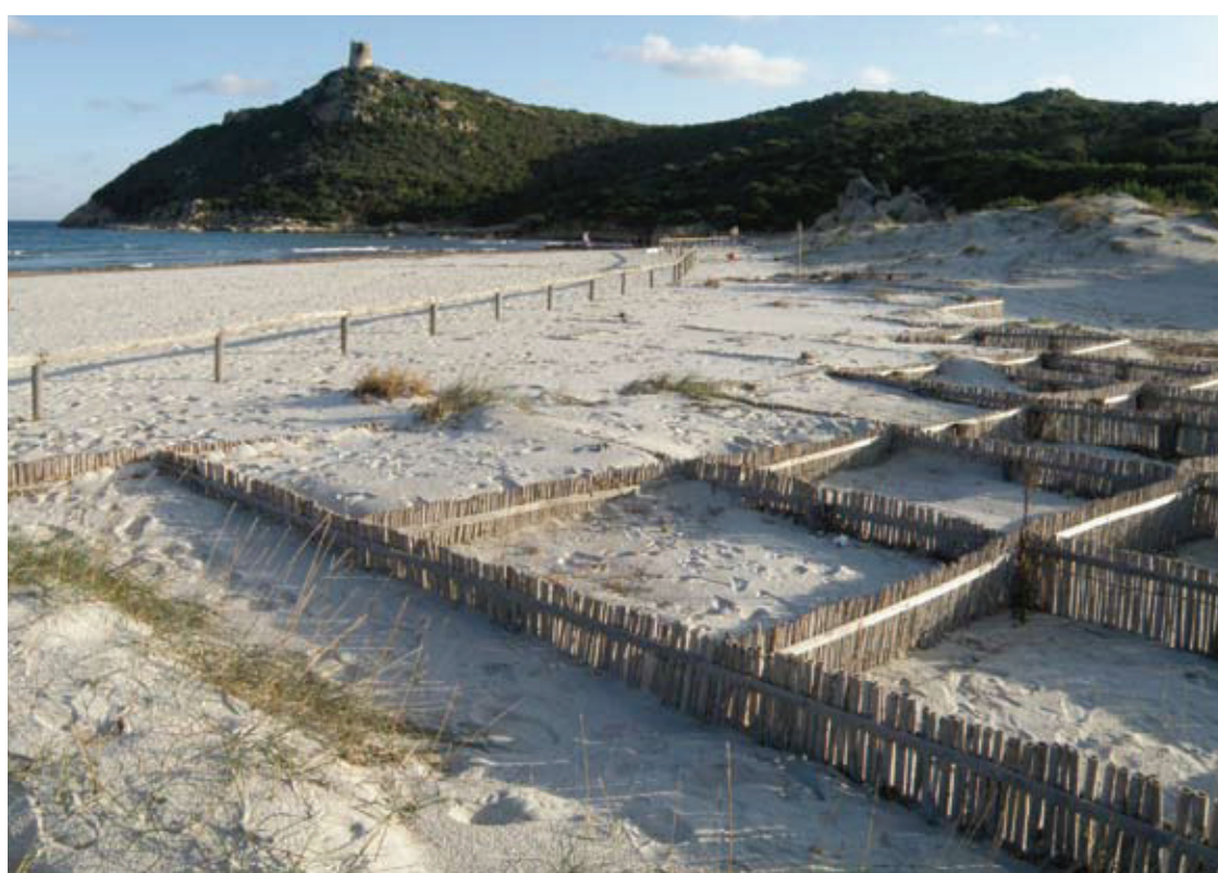
Mitigazione dell'erosione costiera attraverso l'installazione di scacchiere frangivento per l'intrappolamento delle sabbie e la ricostruzione dei sistemi dunari nel litorale di Villasimius (CA). (Foto Criterium).
